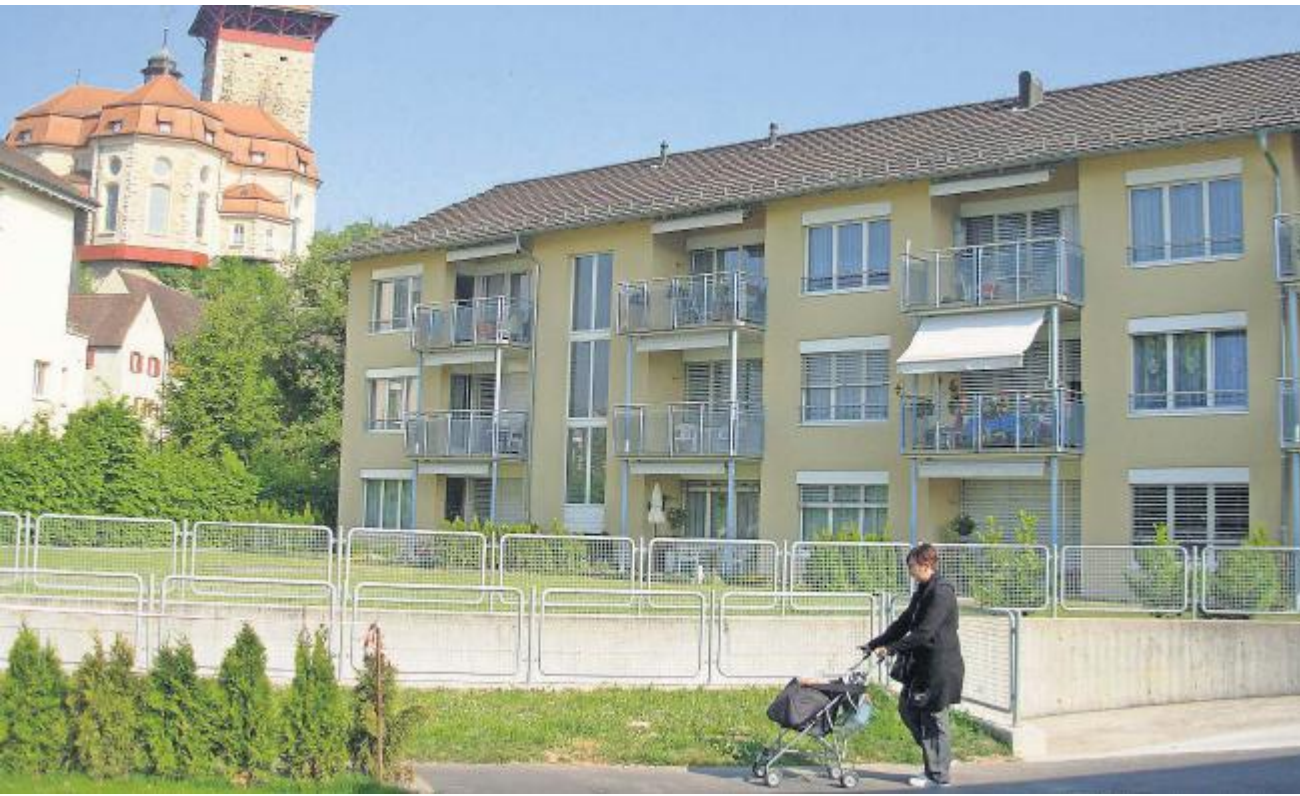
Keine unplanmässigen Unterhaltsarbeiten nötig: Wohnbaugenossenschaft Alterswohnungen hat ein ruhiges Jahr hinter sich.
