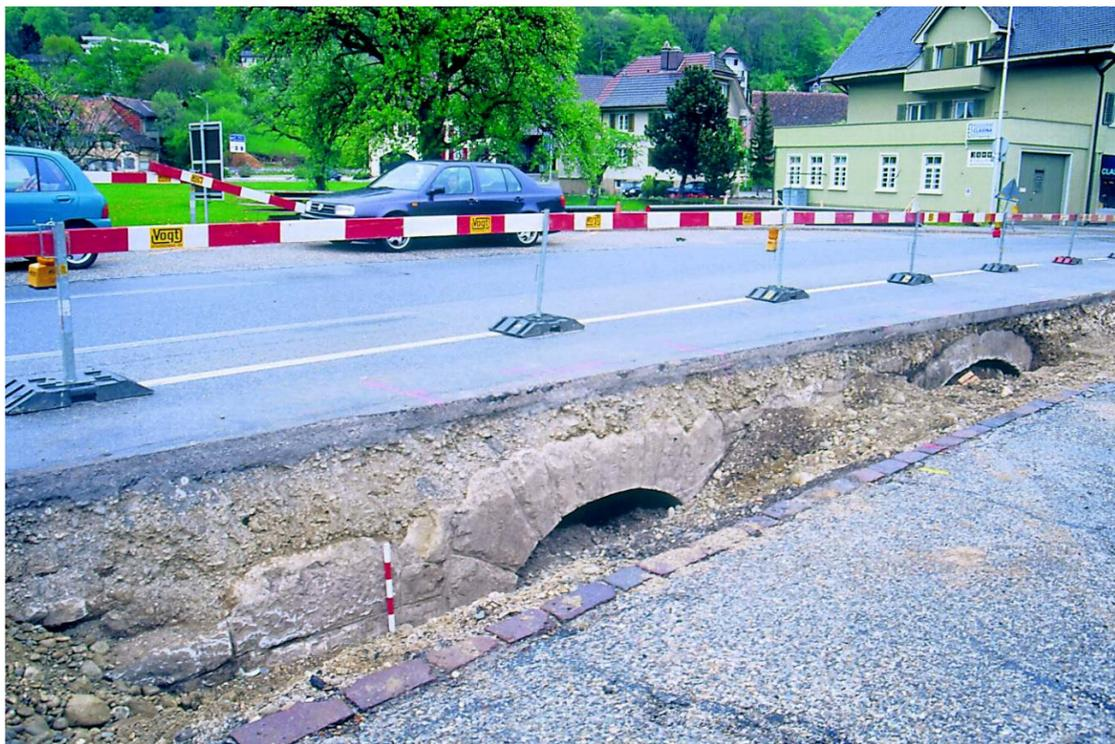
Bei Sanierungsarbeiten an der Solothurnstrasse in Oensingen 2002 kam unter der Strasse ein 60 Meter langer Damm mit sechs Brückengewölben zum Vorschein. Bis zur Dünnerkorrektur 1933/43 hatte der Damm die Strasse vor Hochwasser geschützt, das Wasser floss durch die Gewölbe. KANTONSARCHÄOLOGIE SOLOTHURN
