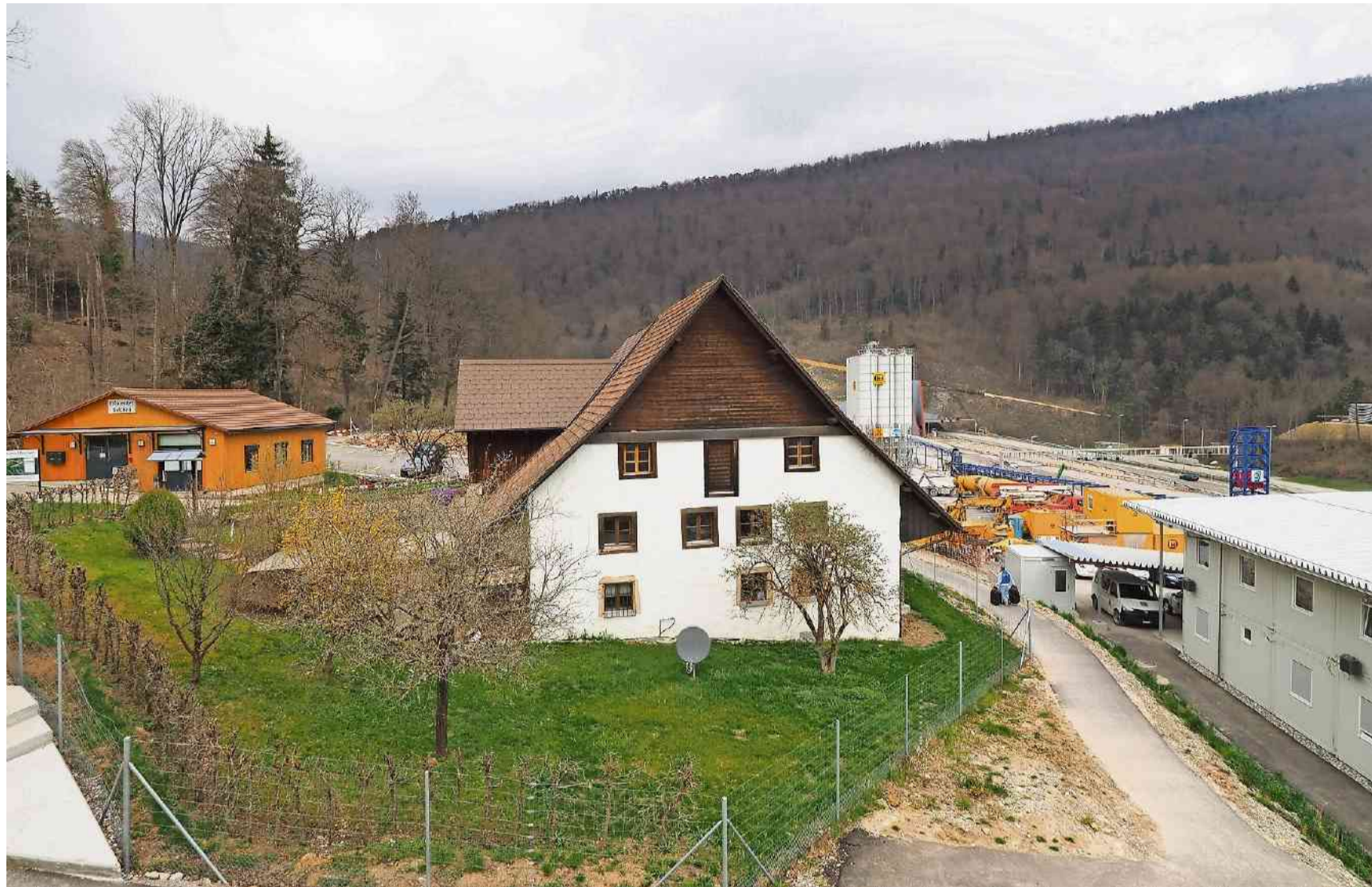
Hof und Tälchen Richenwil («beim Gehöft des Richo», erstmals erwähnt 1423) in Hägendorf sind zurzeit geprägt von der Baustelle für die dritte Röhre des Belchentunnels der Autobahn (links: Besucherpavillon, rechts Büro- und Wohncontainer).
