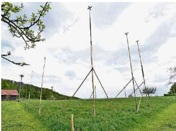
Hier wird Mitte August mit dem Aushub begonnen.
